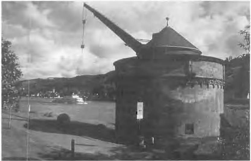
Am alten Kran (1554) von Andernach.
